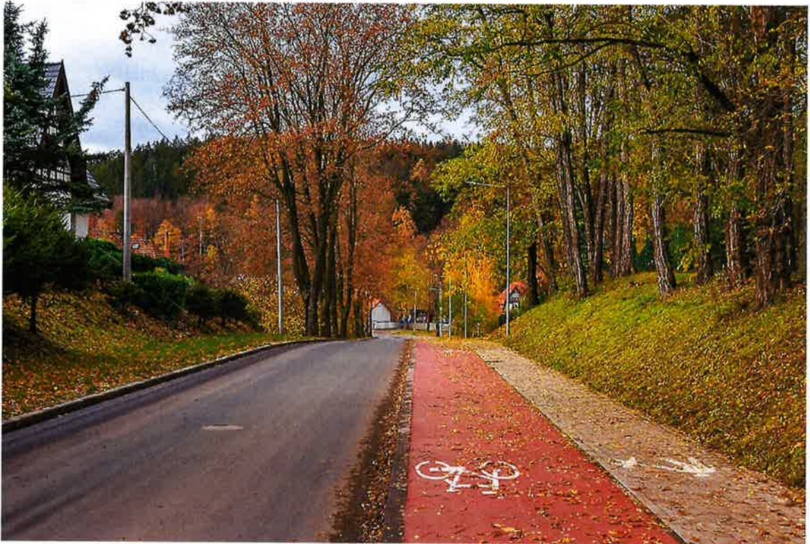
Przebudowana ul. Zwycięzców
