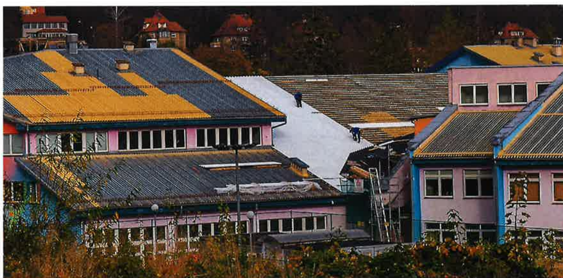
Remont dachu hali sportowej przy Szkole Podstawowej Nr 2 im. Żołnierzy z Monte Cassino
